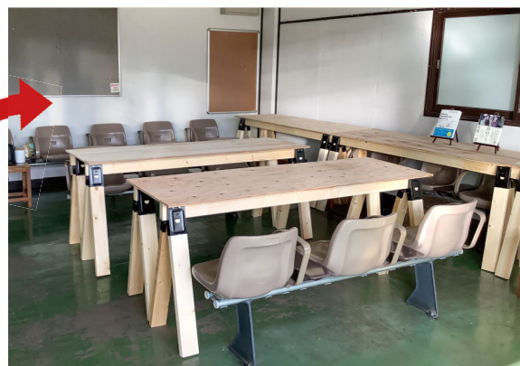
▲ 完成した待合室の様子
