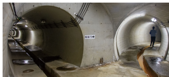
▲ 袖の沢排水トンネルの内部。延長は785㌥に及ぶ。
